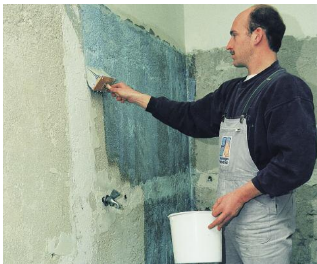
PCI Gisogrund verbessert die Festigkeit und Tragfähigkeit alter, sandender Putze und erhöht die Haftung von Fliesen, Putzen und Tapeten.
