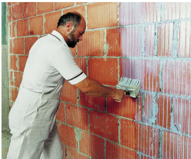
PCI Gisogrund verbessert die Haftung von Gips- und Kalkgipsputzen an Ziegelmauerwerk.
