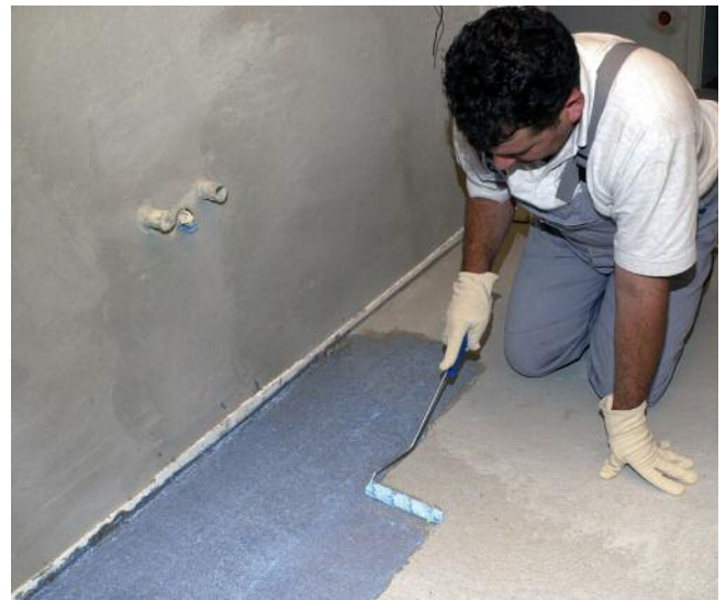
PCI Gisogrund schützt Ausgleichsspachtel und Dünnbettmörtel vor zu schnellem Wasserentzug, verlängert die klebefähige Zeit, verbessert die Haftung und vermeidet die Bildung von Schwundrissen.
