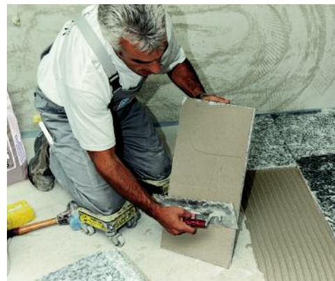
Zum hohlraumfreien Verlegen wird grundsätzlich eine Mörtelschicht auf die Plattenrückseite aufgetragen.
