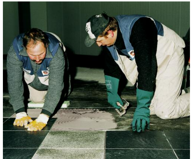
Mit PCI Carrament können Naturwerksteinbeläge sicher im Mittelbettverfahren verlegt werden.
